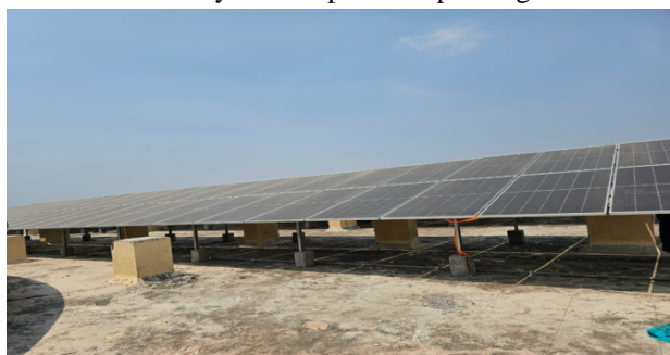
Fig 6:Solar Module 545wt (waaree)
