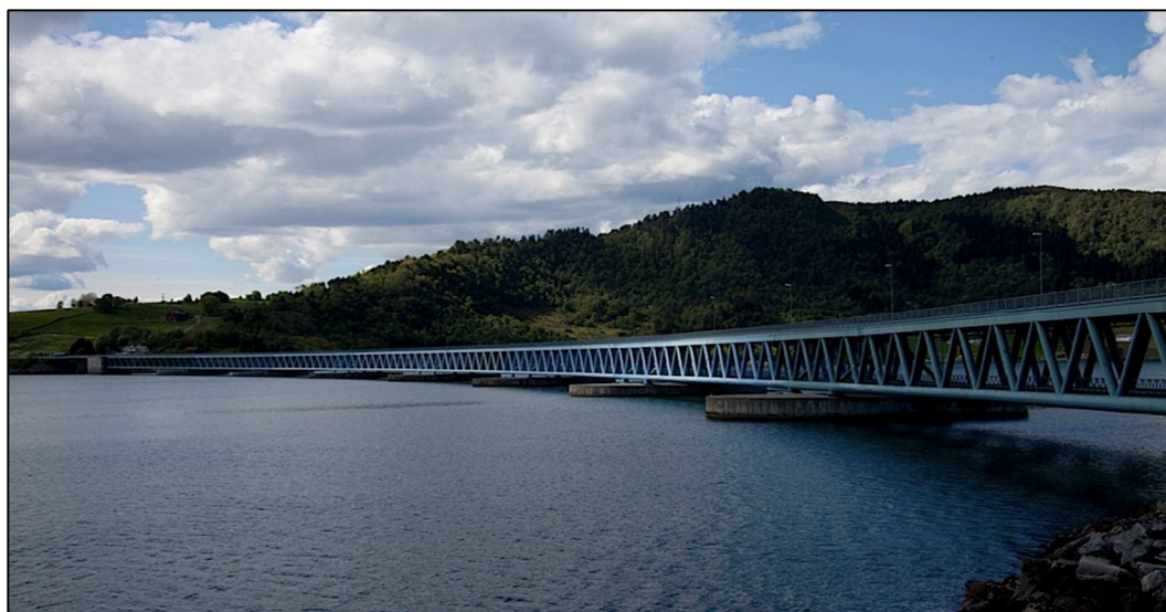
[Fig. 1. Bergsoysund Bridge]
