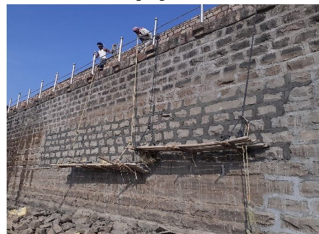
(d) Pointing with crytalline mortar at dam u/s 2d
