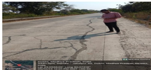
Longitudinal Cracks
