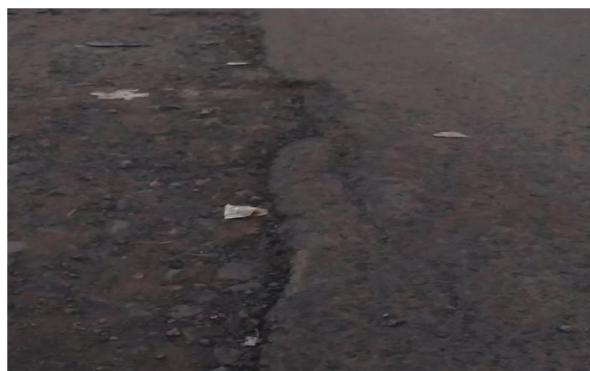
Fig:- Edge Cracking
