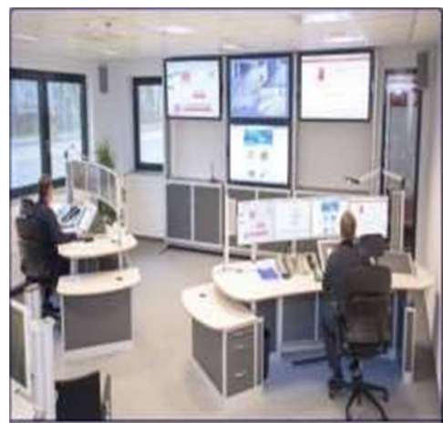
(d) Emergency Control Station
